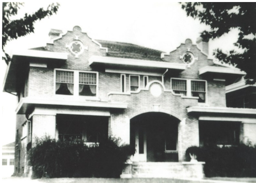
La reconstrucción y restauración del parapeto y las ventanas abuhardilladas del ático en 311 NW 19th Street se logró con la ayuda de una fotografía histórica (arriba: construcción histórica; arriba a la derecha: antes de la restauración; abajo a la derecha: después de la restauración).
