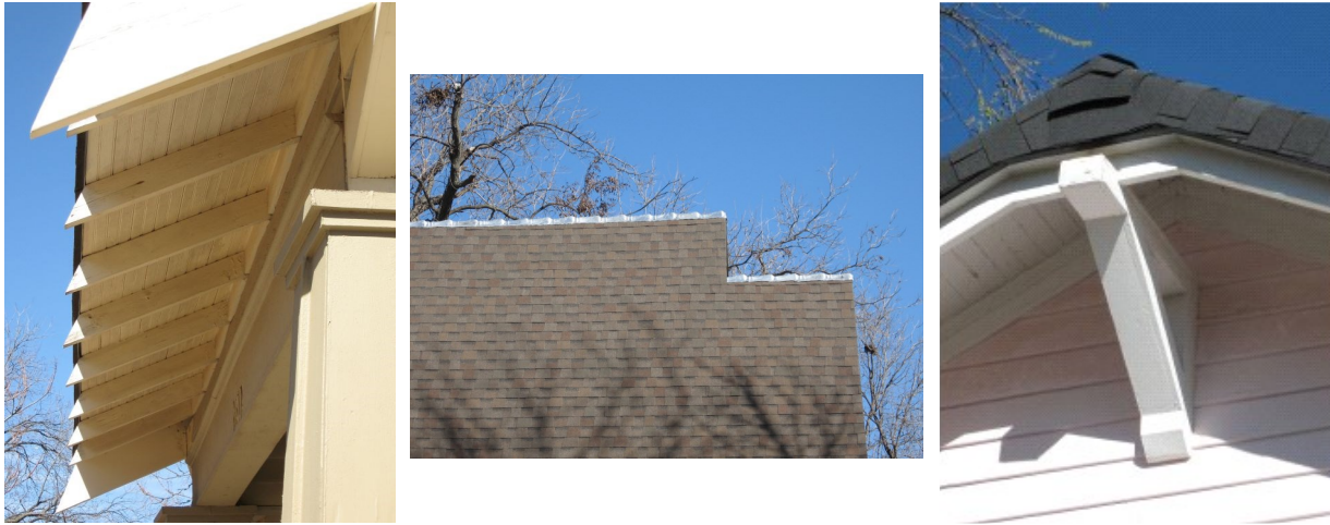
Se deben conservar los elementos originales del techo, como los extremos de las vigas (a la izquierda: 2612 N. Hudson), las tejas de cumbrera (centro: 905 NW 38th Street) y las ménsulas,
