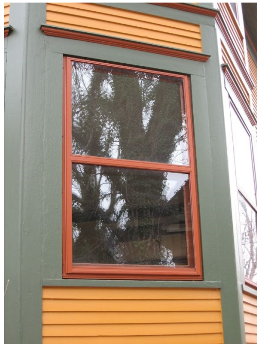
Esta vivienda de estilo Foursquare estadounidense ubicada en 610 NW 17th Street usa colores de pintura para resaltar las molduras, las columnas del porche y las ventanas.
