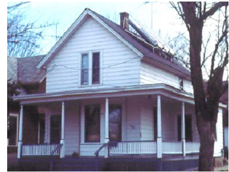
Izquierda: una ubicación apropiada para los paneles solares, fuera de la vista del público y protegidos en un patio trasero; derecha: los paneles solares no se deben ubicar en líneas de tejados que sean visibles desde la vía pública.
