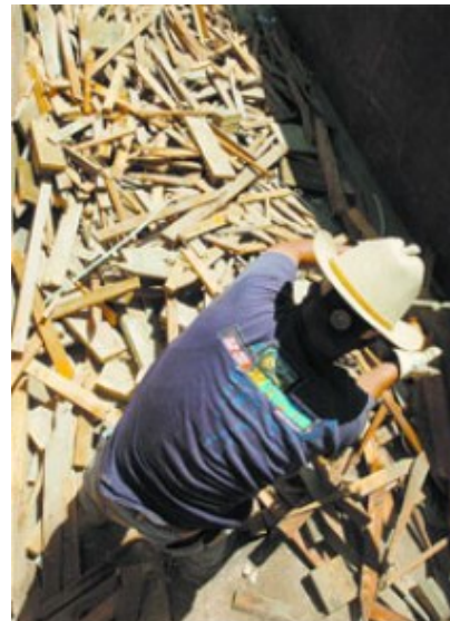
Los escombros de los edificios que se demuelen representan aproximadamente un tercio del volumen de los vertederos.
