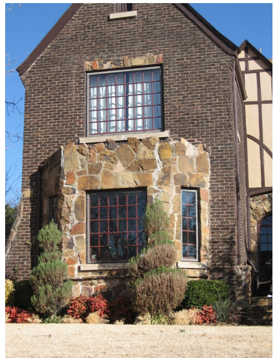
Las directrices de diseño enfatizan la necesidad de preservar los materiales originales que ilustran el estilo y el carácter, como el exterior de piedra y ladrillo, y las ventanas originales de la vivienda ubicada en 805 NW 40th Street.
